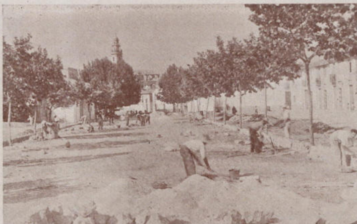
El Paseo Cervantes en plenas obras de urbanización
