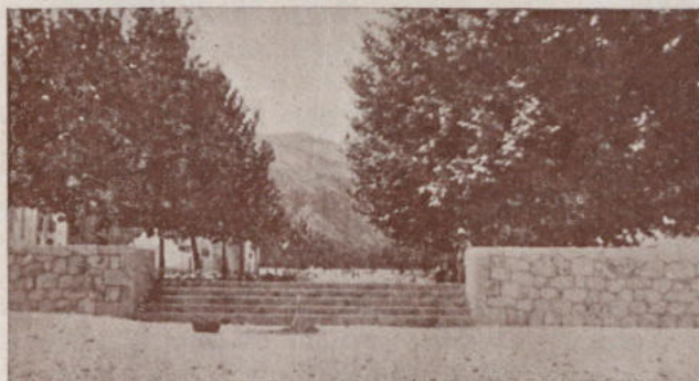
Estado de la entrada al Paseo Cervantes
