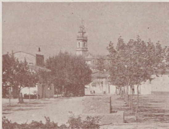
El Paseo Cervantes antes de las obras
