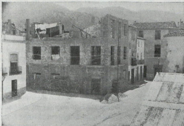
Hogar del Camarada. Estado actual de las obras
