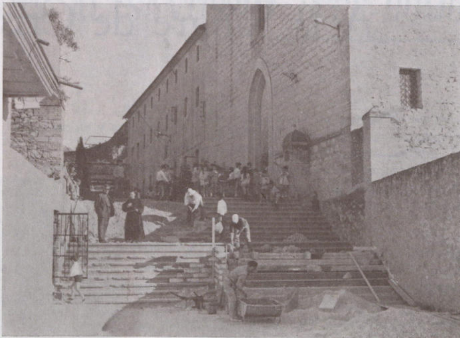
Actual estado de la reforma de la escalera de acceso al Convento
