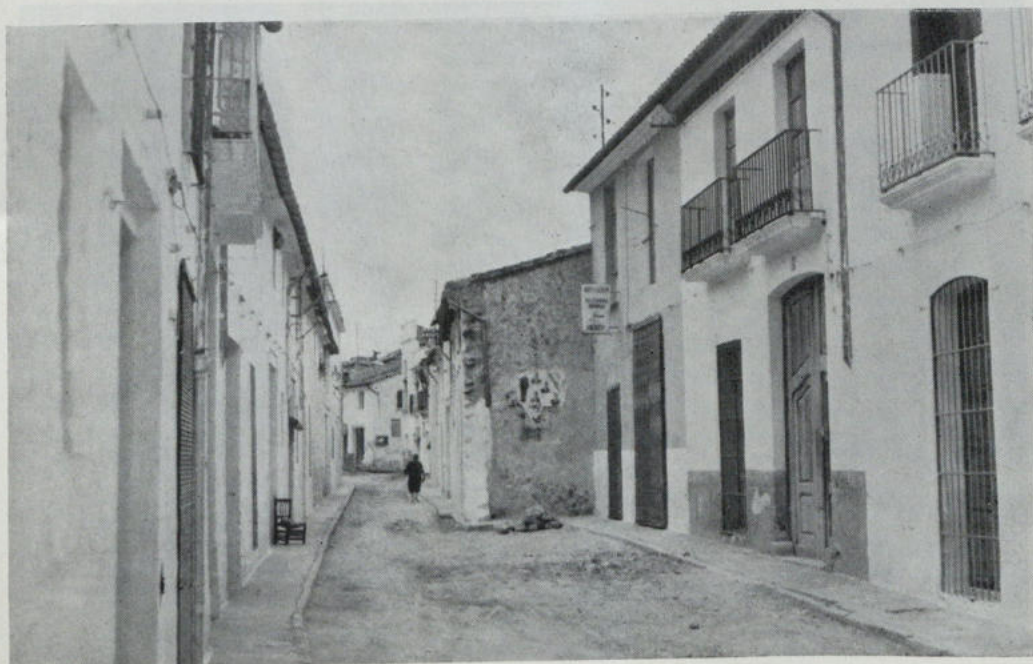
Calle Carrasqueta antes de las obras de ensanche
