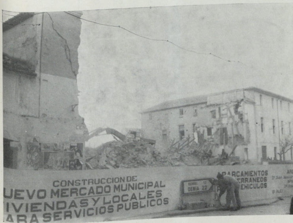
En plena tarea de derribo
