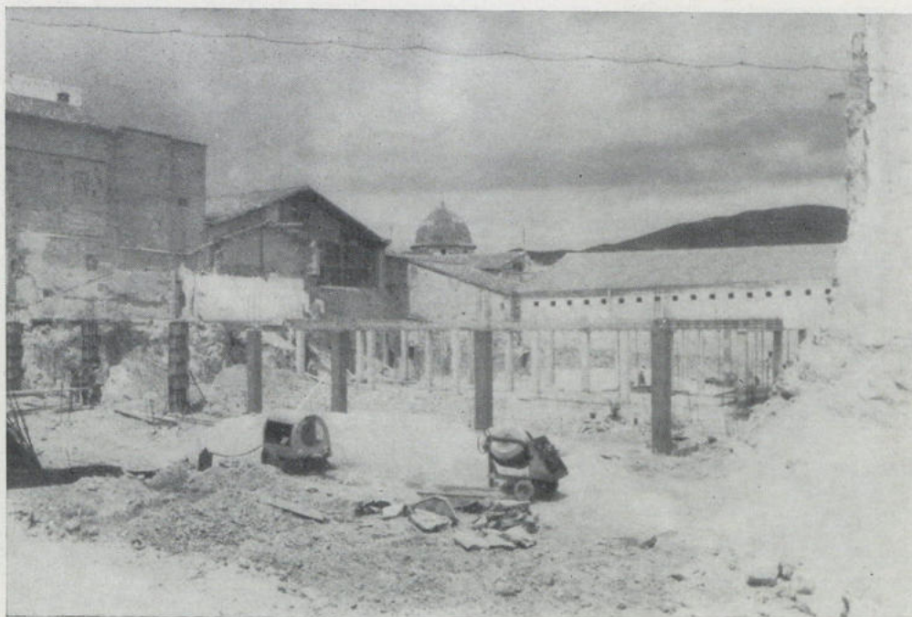
Estado actual de las obras
