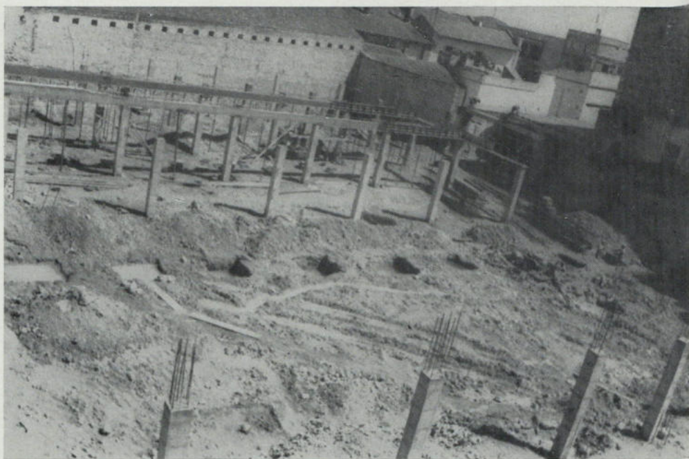
Otra perspectiva del estado actual de las obras
