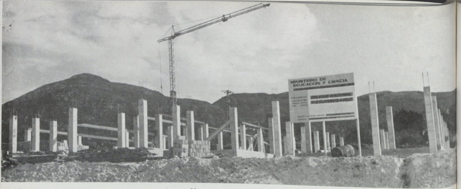
Obras del nuevo Grupo Escolar
