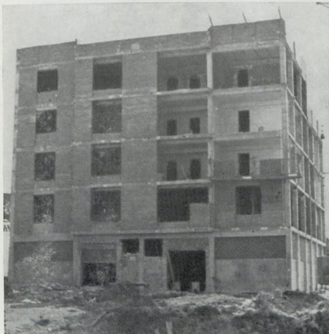
Bloque de viviendas de renta limitada que construye el Ayuntamiento en la calle Calvario Viejo
