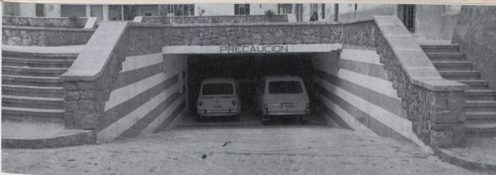
Entrada aparcamiento subterráneo de vehículos
