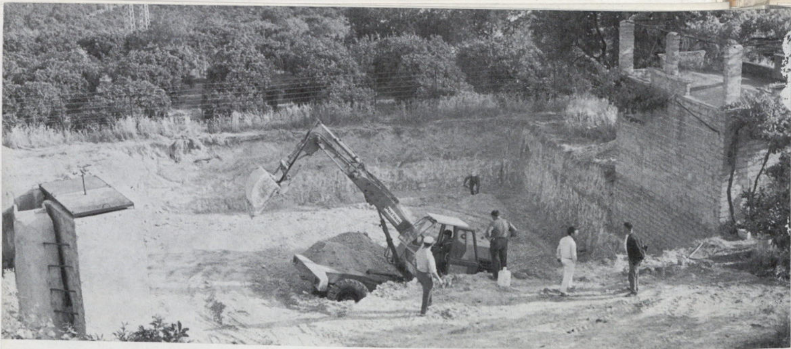
Aguas Potables. Obras nuevo depósito.
