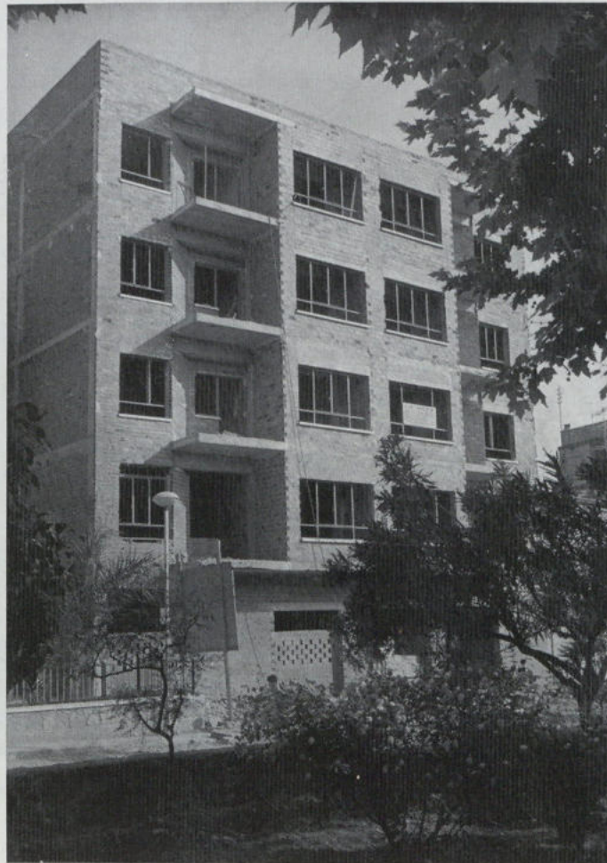
Viviendas subvencionadas para funcionarios en Paseo Cervantes
