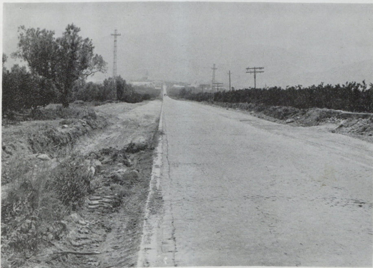
Estado actual de las obras de la carretera Pego-Oliva
