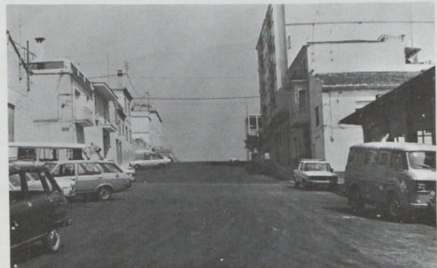
Aquesta es l'Avenguda de Fontilles una vegada les obres de pavimentació acabades.
