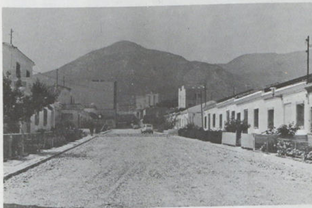
Pavimentació dels carrers de les Cases Barates.
