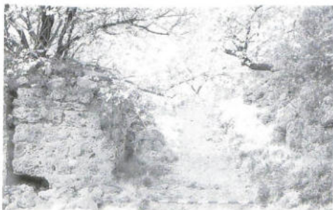
Ingrés a l'interior del recinte. Portal (vestígit)
