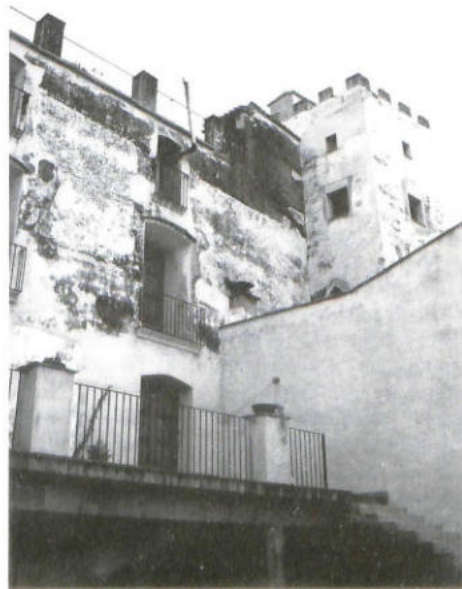
Un dels trams millor conservats de la muralla, amb dos torres. Cantonada M. Blasco/Sant Lluís.
