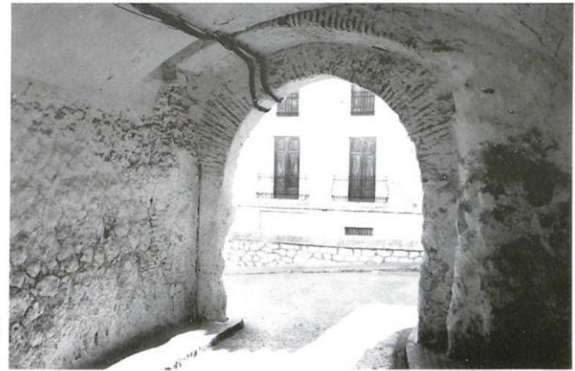
Vista interior del Portalet, on s'hi pot apreciar el guix del mur i la volta a ell adossada.
