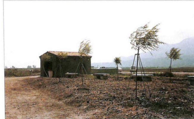
Sala de bombeo, Partida Estalons
