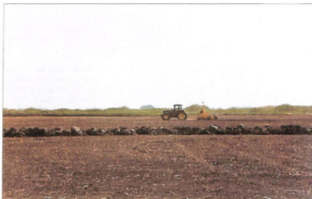
Nivelación del terreno, mediante laser
