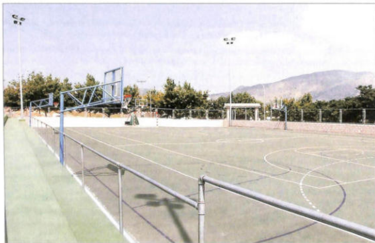
2.- Reforma y Construcción pista polideportiva con gradas, pavimento slurry con reforma y ampliación del alumbrado.
