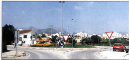
Acceso a Pego (Trilladora). Rotonda ajardinada.
