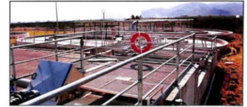
Depuradora Aspecto Interior.
