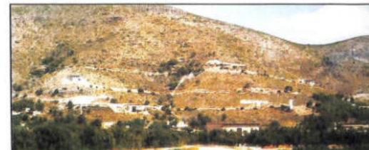
Urbanización Monte Mostalla un proyecto residencial al lado de nuestro pueblo.
