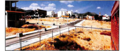
Urbanización Calles. Alter de Pau.
