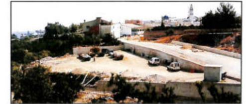
Obras en el Molinet del Curro. Construcción ECOPARK.
