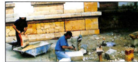
Restauración fachada colegio Cervantes por picapedreros.
